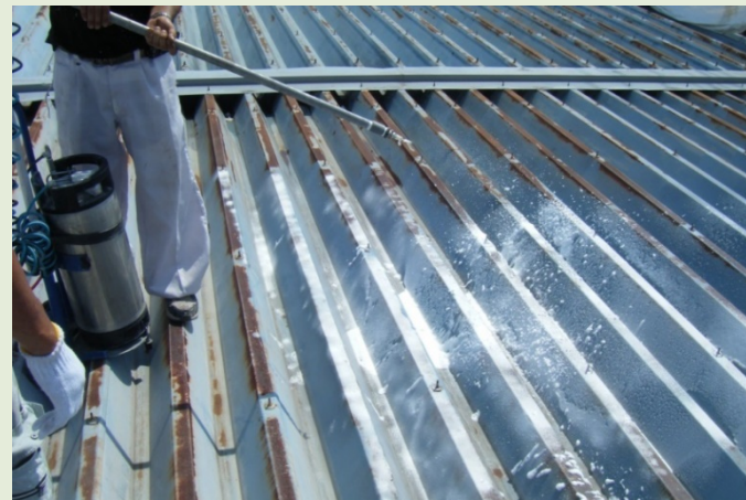
ラストスーパー タイプFの発泡処理
