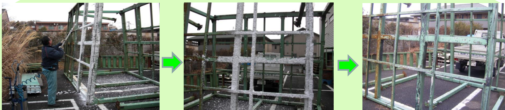
発泡タイプによる工場屋根(600㎡)の錆取り・防錆
